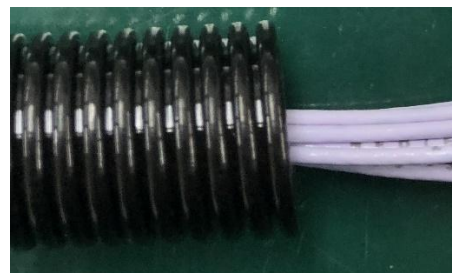
コンジットチューブ(挿入後)
